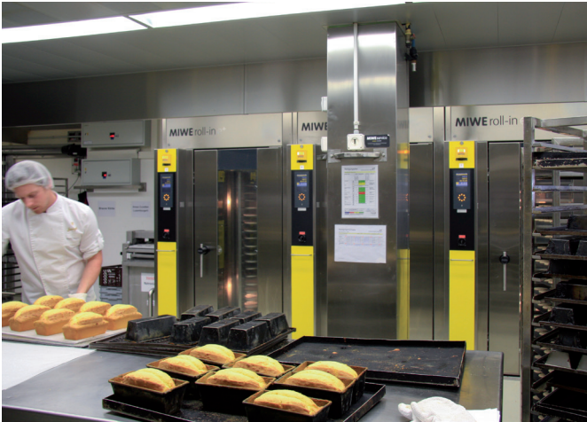
In einem Hub wurden die roll-in e+ eingebracht und sauber integriert.
