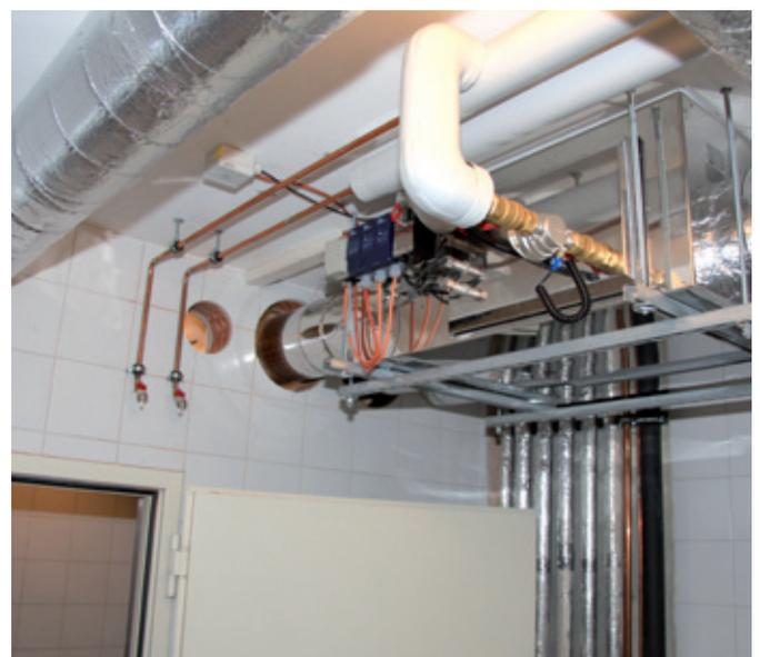
In einem Nebenraum werden die Abgasrohre der beiden Stikkenöfen in die MIWE eco:box zusammengeleitet.
